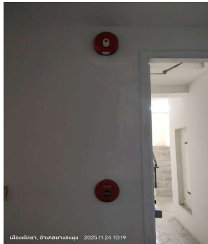
ภาพที่ 43 ระบบแจ้งเหตุไฟไหม้ (Fire Alarm)
