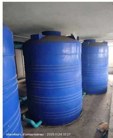
ภาพที่ 10 แสดงถังเก็บน้ำสำรองคาตฟ้า
