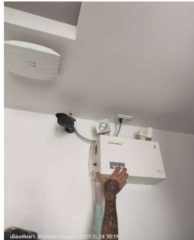
ภาพที่ 40 แสดงไฟส่องสว่างฉุกเฉิน
