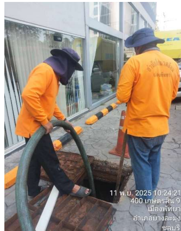
ภาพที่ 8 แสดงการสูบน้ำจากบ่อบำบัดน้ำเสีย
