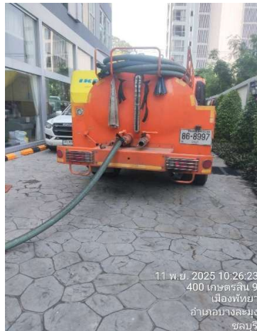
ภาพที่ 7 แสดงการสูบน้ำจากบ่อบำบัดน้ำเสีย
